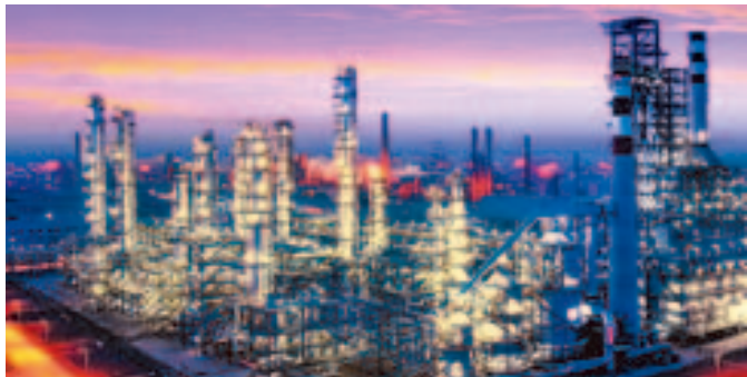
中国石化天津百万吨级乙烯炼化一体化项目
